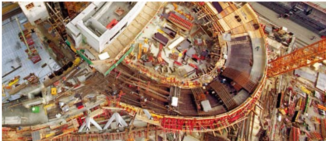
Die Baustelle Mercedes-Benz Museum in Stuttgart aus der Vogelperspektive
